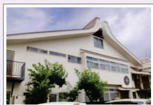
〔補修後の外観〕
